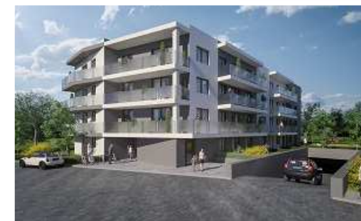
Budynek przy ulicy Budowlanych w Górze Kalwarii
